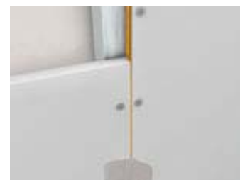
Rebouchage des surfaces après la réalisation du joint colle
